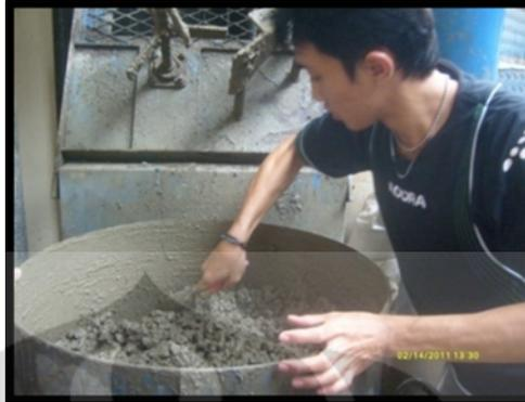
Gambar 3.9 Pengadukan Beton dengan Mesin
