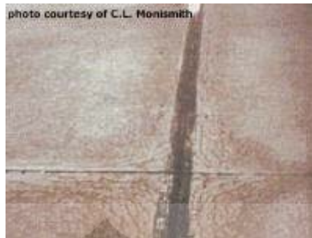
Gambar 2.15 Retak Daya Tahan
