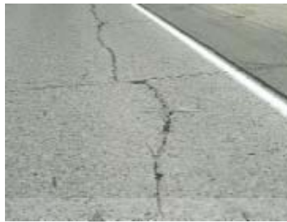
Gambar 2.9 Retak Memanjang
