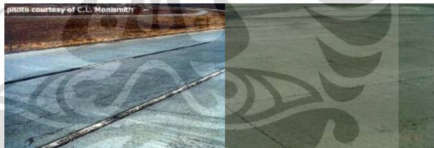
Gambar 2.12 Retak Susut
