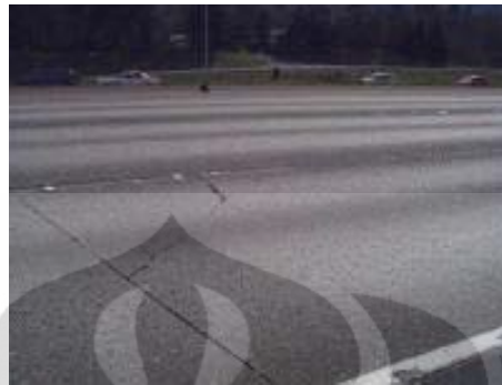
Gambar 2.11 Retak Sudut
