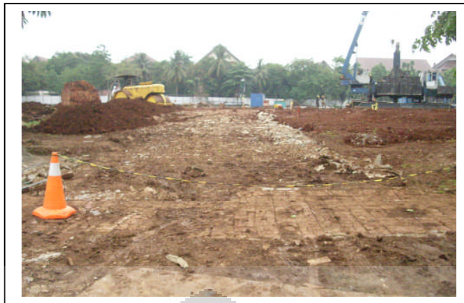
Gambar 4.5. Lokasi penelitian TL FKM setelah dilakukan pembangunan [Sumber: Dokumentasi pribadi, 2011.]
