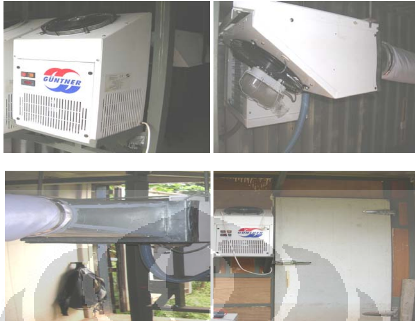
Gambar 3. 2. Letak Alat Plug In Refrigeration Unit GEKN 1200.
