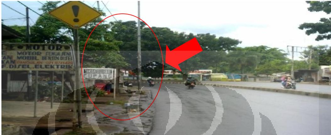
Gambar 4. 20 Kondisi daerah bebas samping di tikungan yang sudah tidak memadai
