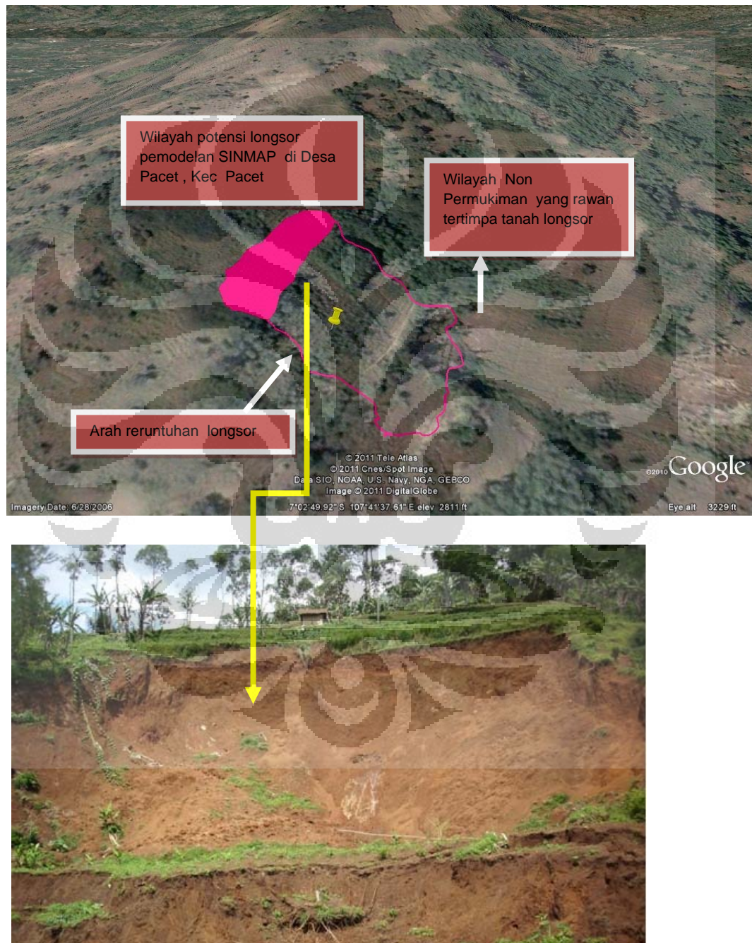
Gambar 5.8 Lokasi Non Permukiman Rawan Longsor
