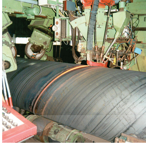
Gambar 2.4 Proses pabrikasi pipa yang dilas spiral
