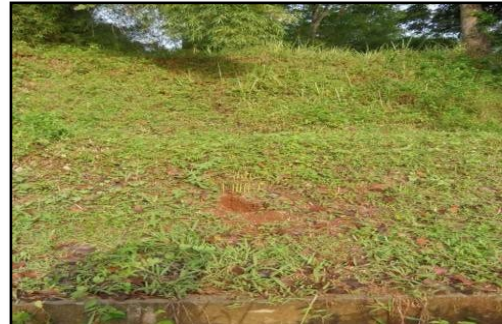
Gambar 5.5 Laju Erosi Sedang di Sebelah Timur Asrama UI Depok
