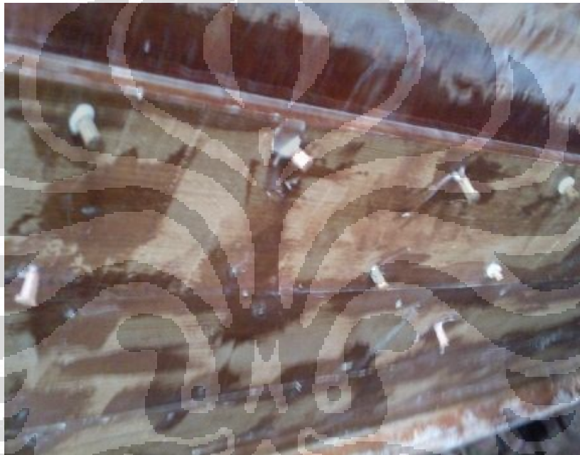
Gambar 4.9 Cara menutup lobang bekas sekrup dengan pasak
