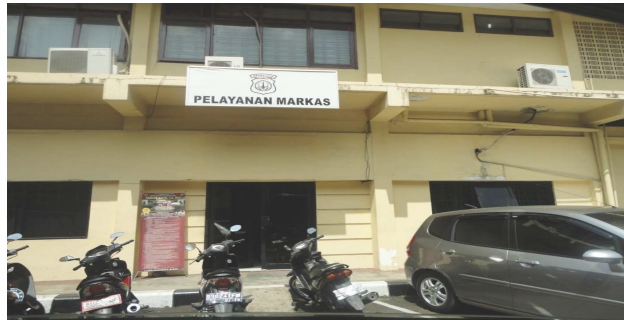
Gambar 1 : Kantor Pelayanan Markas (Yanma) Polda Metro Jaya Sumber : Data sekunder Polda Metro Jaya
