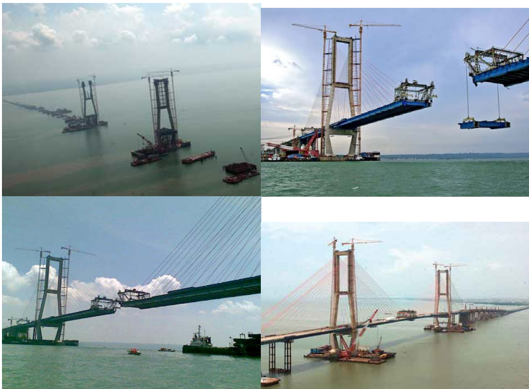
Gambar 4.6 Foto-Foto Pelaksanaan Konstruksi Jembatan Suramadu
