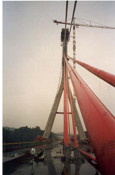
Gambar 2.45 Proses Penarikan Kabel
