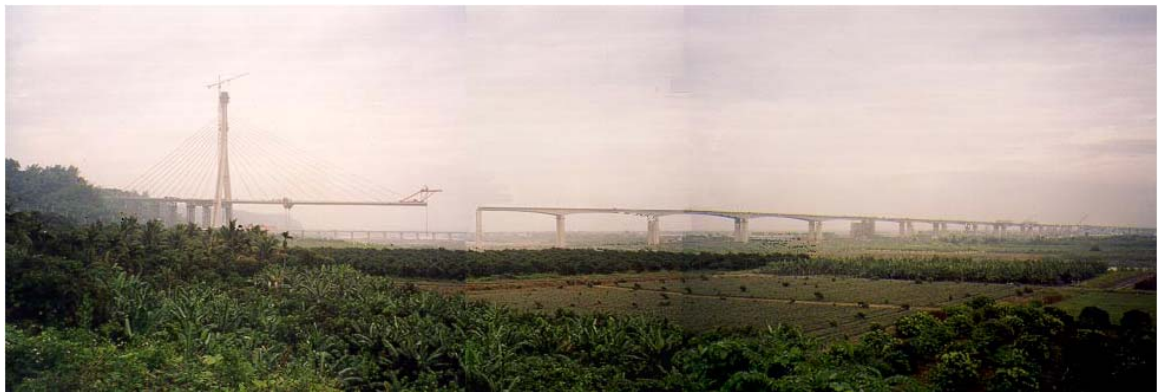
Gambar 2.42 Proses Pelaksanaan Jembatan Kao Ping Hsi
