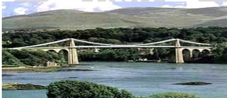
Gambar 2.1 Jembatan Suspension Menai
