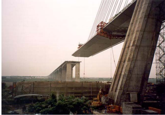
Gambar 2.44 Tahapan Konstruksi Gelagar
