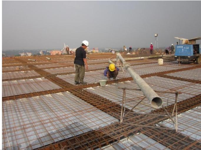
Gambar 4.7 Pengecekan Tulangan Pelat/Balok Sebelum Pengecoran
