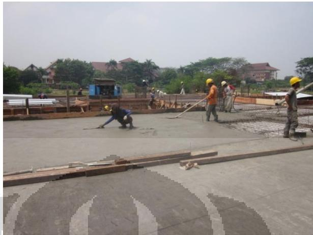
Gambar 4.16 Perataan Permukaan Beton Setelah Dipadatkan
