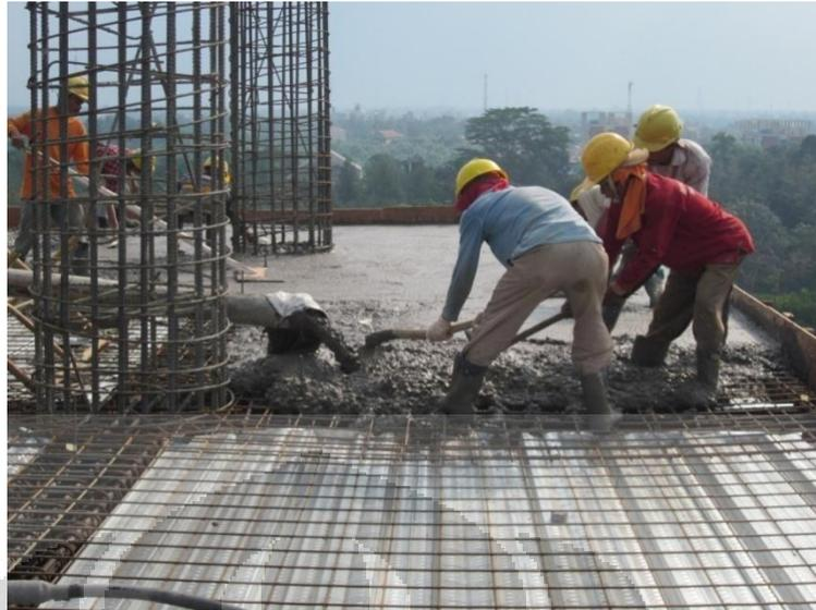
Gambar 4.14 Pengecoran Pelat/Balok di Lantai 7
