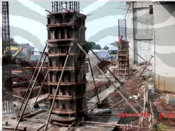
Gambar 4.5 Tulangan di dalam Bekisting Kolom Berbentuk Balok
