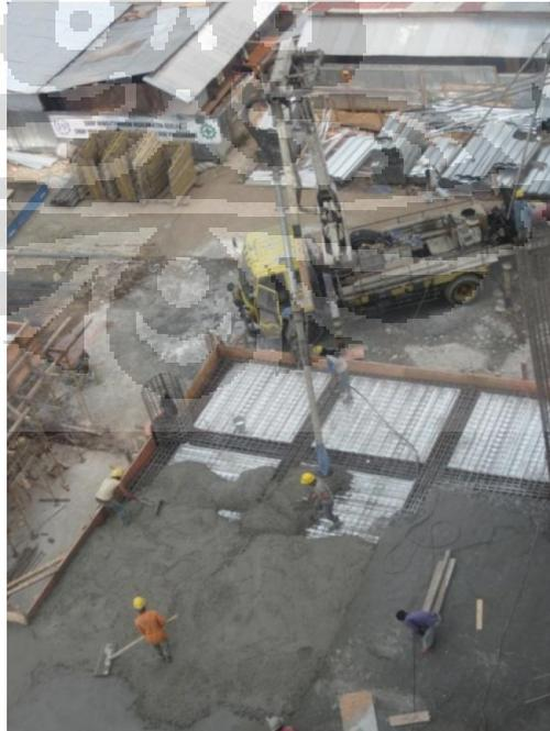
Gambar 4.17 Pengecoran Pelat/Balok Menggunakan Pompa
