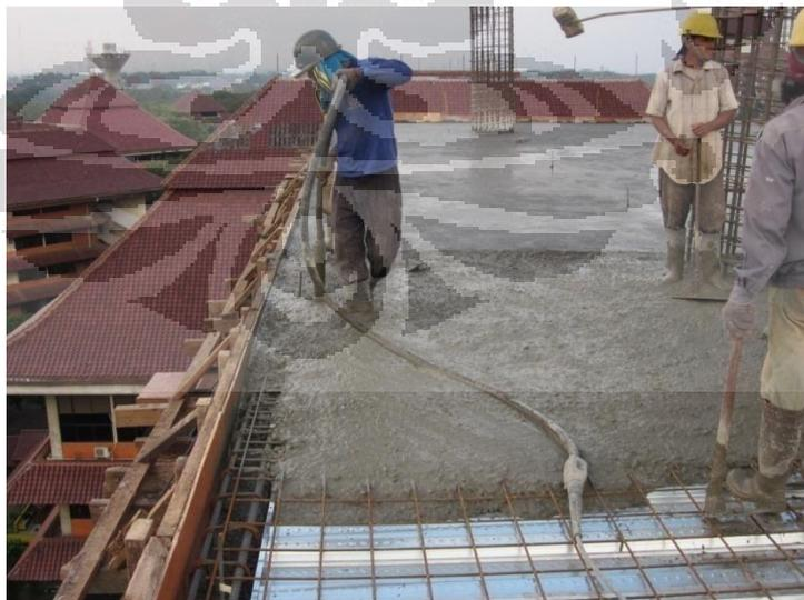
Gambar 4.15 Pematatan Beton Menggunakan Vibrator yang Tegak Lurus
