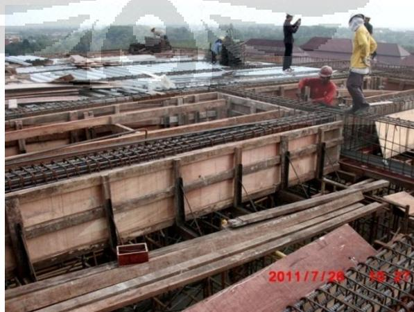
Gambar 4.6 Penulangan dan Pemasangan Bekisting Balok Oleh Tukang
