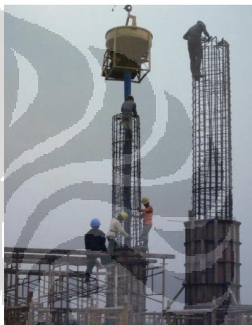
Gambar 5.2 Para Tukang Mengecor Kolom
