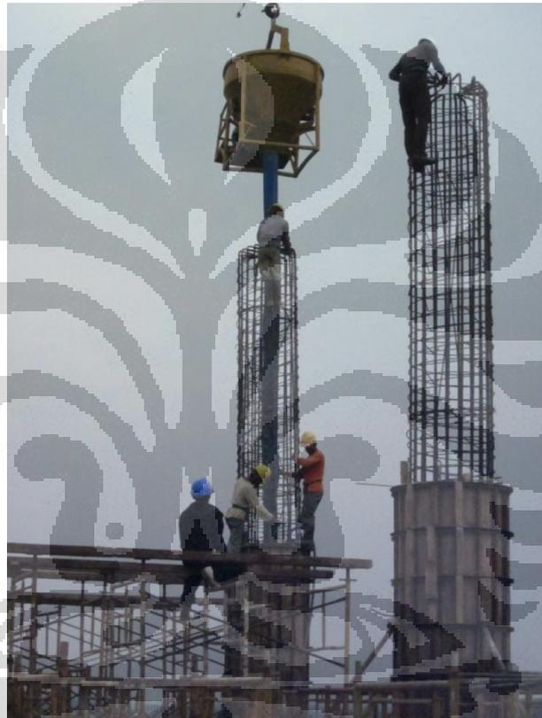
Gambar 4.18 Proses Pengecoran Kolom
