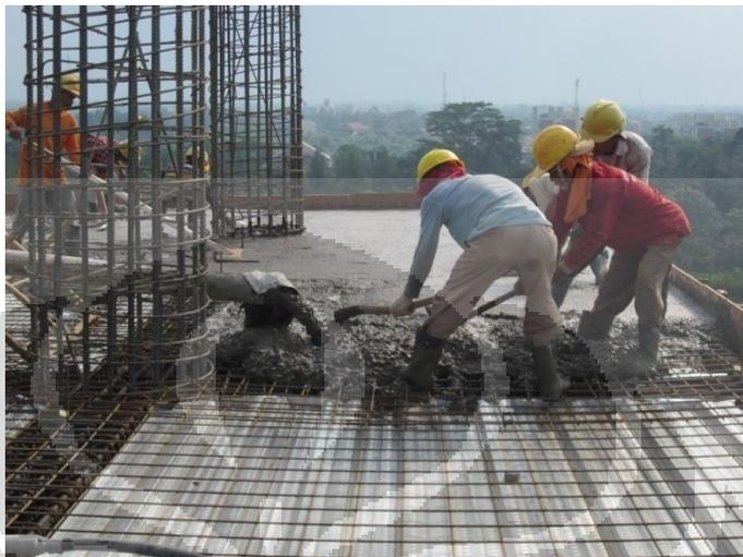
Gambar 5.4 Pengecoran Pelat/balok di Lantai 7
