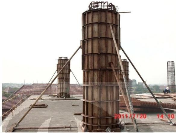
Gambar 4.4 Tulangan di dalam Bekisting Kolom Silinder
