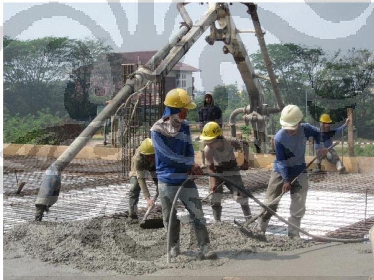
Gambar 4.13 Penuangan *Mix* Beton Menggunakan Pompa Pada Pengecoran Pelat/Balok Bersamaan dengan Perataan oleh Pekerja
