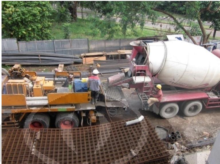
Gambar 4.12 *Mix* Beton yang Dialirkan ke *Concrete Pump*
