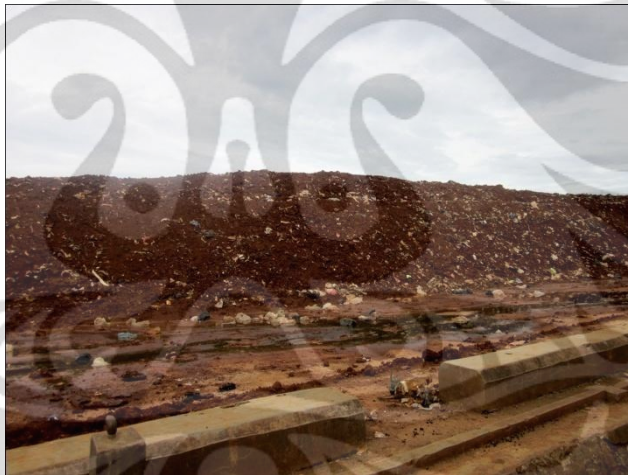
Gambar 4.4. Kondisi Lahan Penimbunan Lama TPA Cipayung Setelah Diberikan Tanah Penutup (Observasi Penulis, 2010)
