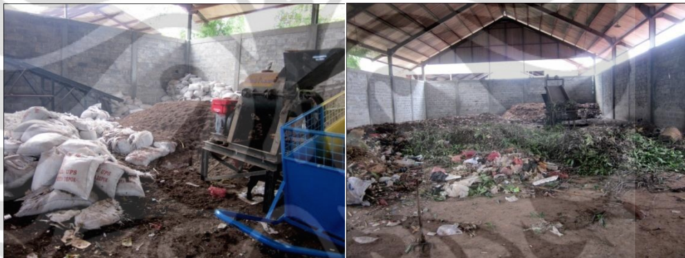
Gambar 4.6. Kondisi Fasilitas UPS di TPA Cipayung (Observasi Penulis, 2010)
