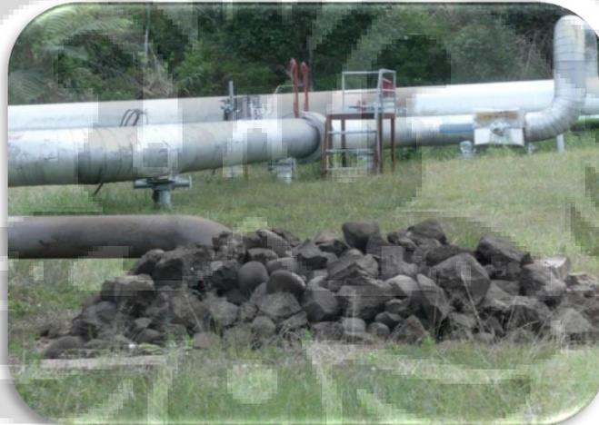
Gambar 5.17. *Rockmuffler* di Lokasi Uji Datar
