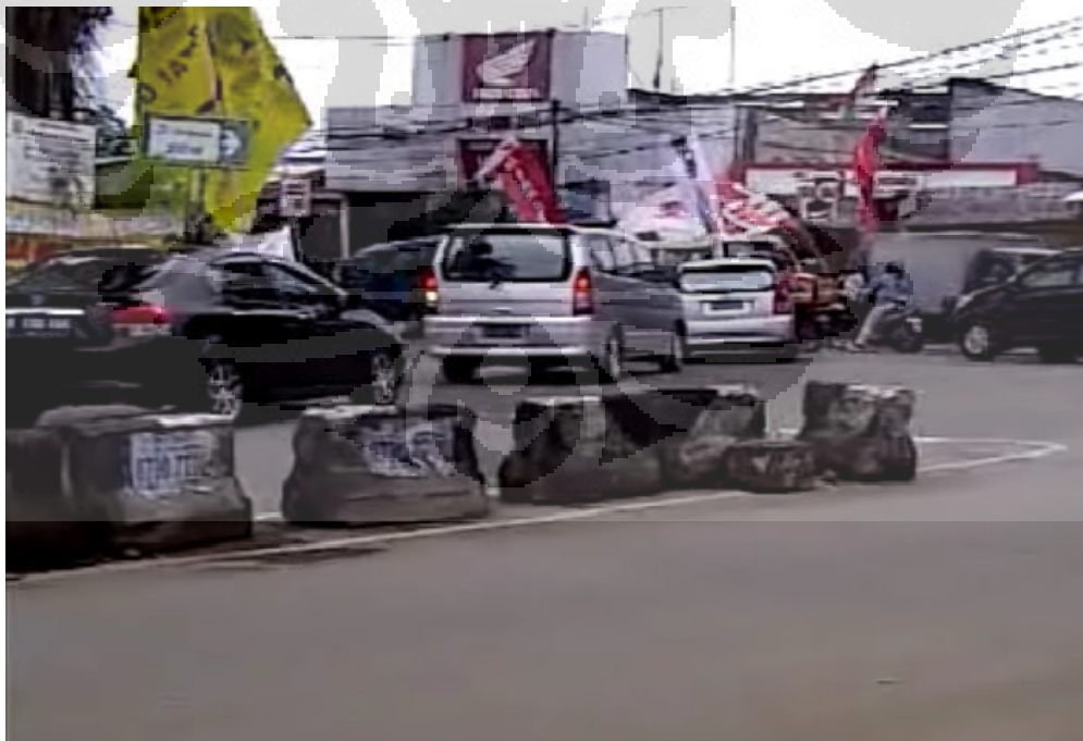
Movable Concrete Barrier (MCB) Pada Persimpangan
