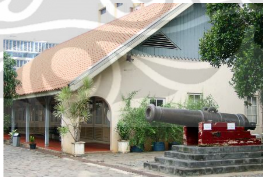
Gambar 3.16 Bangunan kantor museum Fatahillah (dokumen pribadi-Maret 2011)
