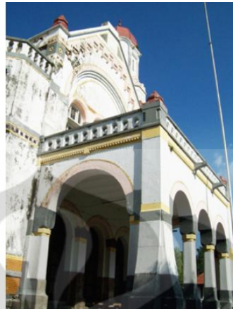
Gambar 3.18 Bagian pintu masuk utama Lawang Sewu (dokumen pribadi-Maret 2011)
