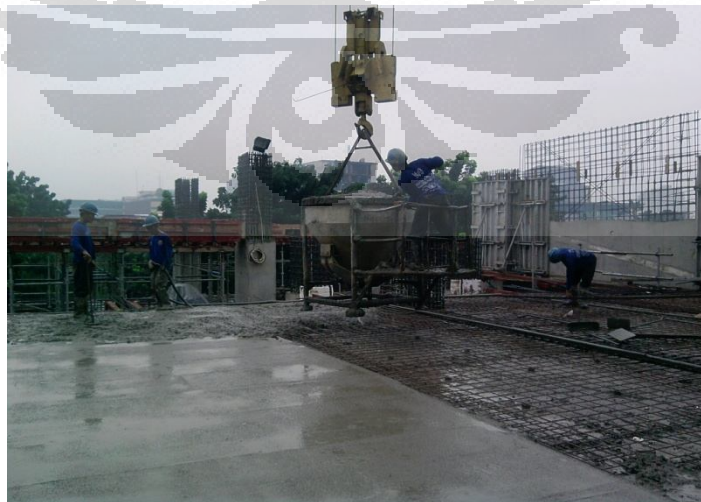
Gambar 5.15 Penuangan Beton Topping (Pengecoran)
