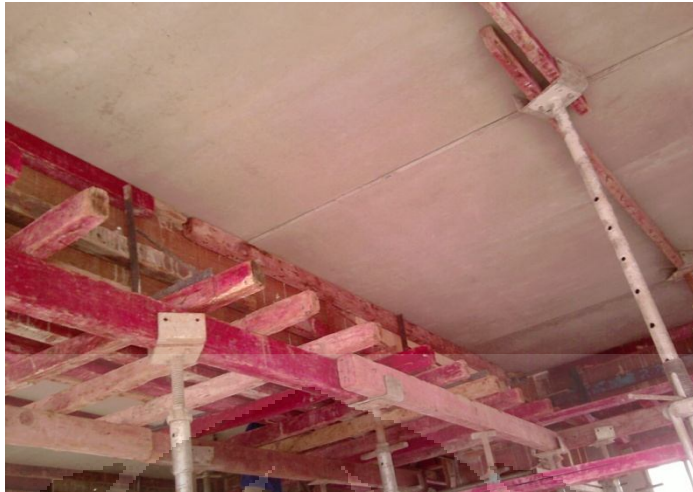
Gambar 5.4 Pemasangan Shoring Pada Pelat Preslab
