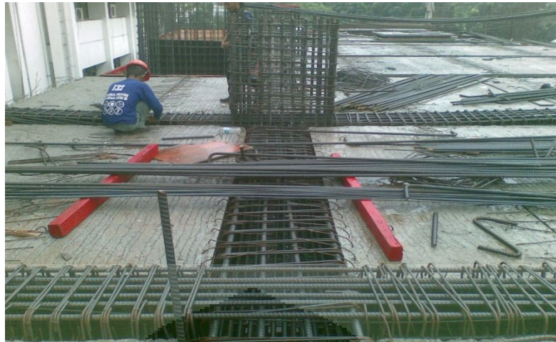
Gambar 5.11 Perakitan dan Pemasangan Tulangan Balok
