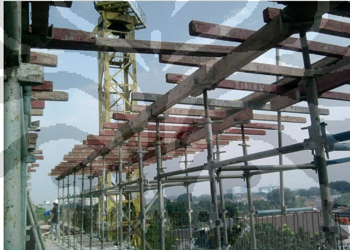
Gambar 5.2 Pemasangan Perancah Bekisting Balok
