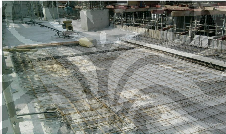
Gambar 5.12 Wiremesh yang Digelar Diatas Pelat Precast
