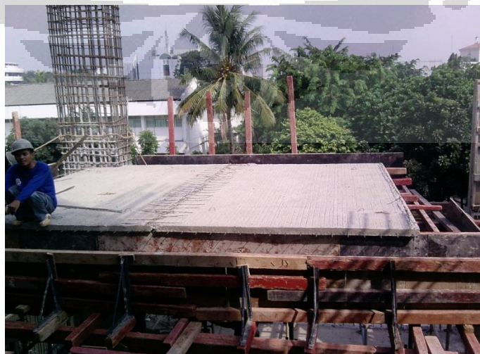
Gambar 5.3 Pemasangan Pelat Preslab Di Atas Bekisting Balok
