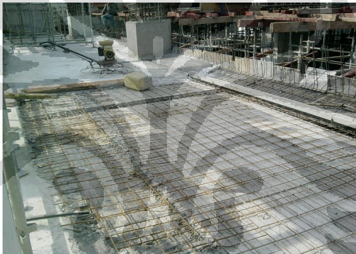
Gambar 5.5 Pemasangan Wiremesh Pada Pelat
