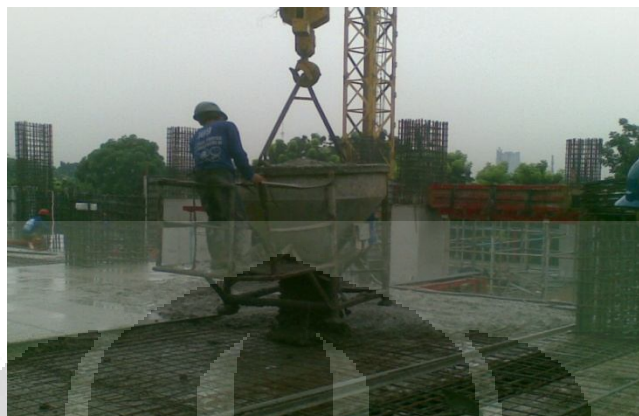
Gambar 4.15 Penuangan Campuran Beton Sebagai Topping Pelat
