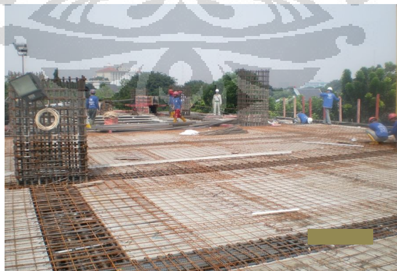
Gambar 5.13 Tulangan Balok dan Pelat yang Sudah Dirakit Menjadi Kesatuan
