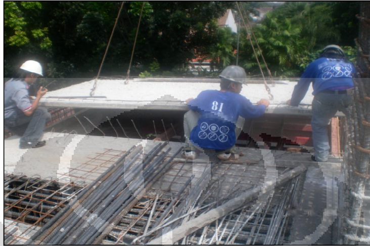
Gambar 4.10 Pemasangan Preslab Dilakukan Secara Perlahan
