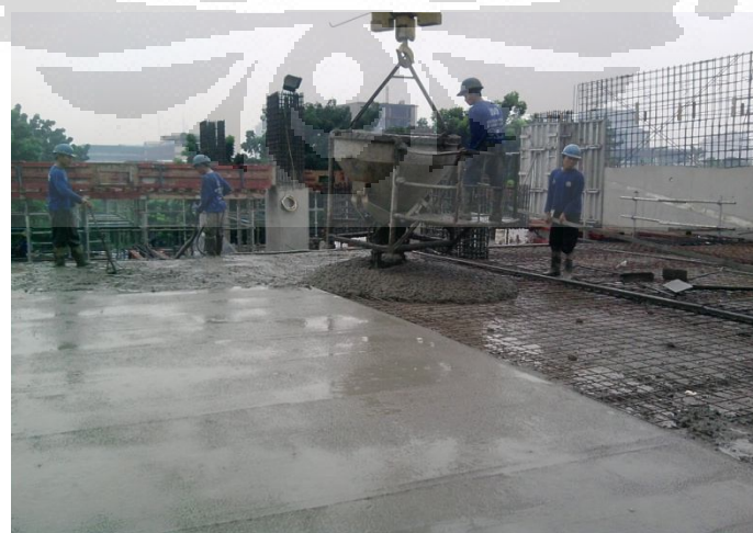
Gambar 5.6 Pengecoran Topping Pelat
