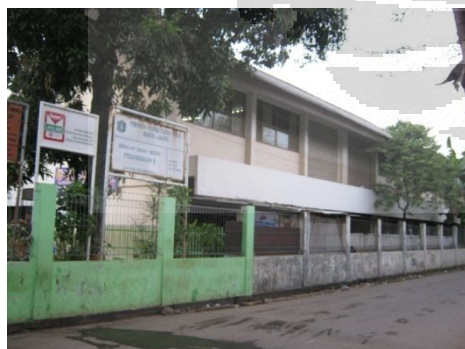
Gambar 3.2 Tampak depan gedung sekolah SDN Pegangsaan II
