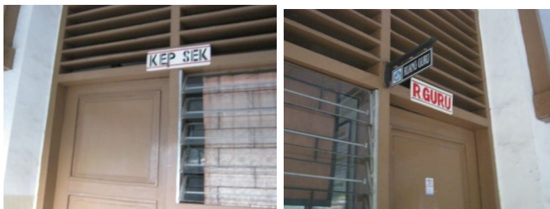
Gambar 3.64 dan Gambar 3.65 Ruang Kepsek dan Ruang Guru SDN 08
