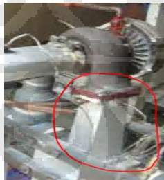
Gambar 5.1 Saluran menuju turbin
