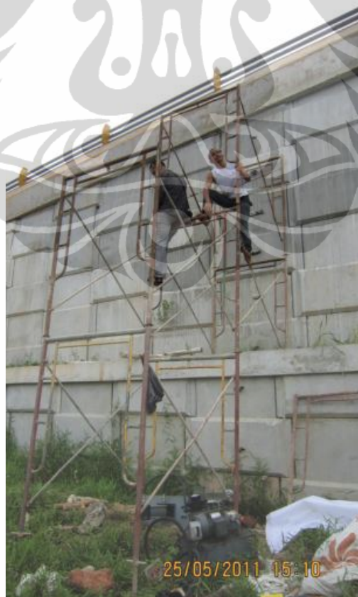
Gambar 3.33. Pemasangan Scaffolding
