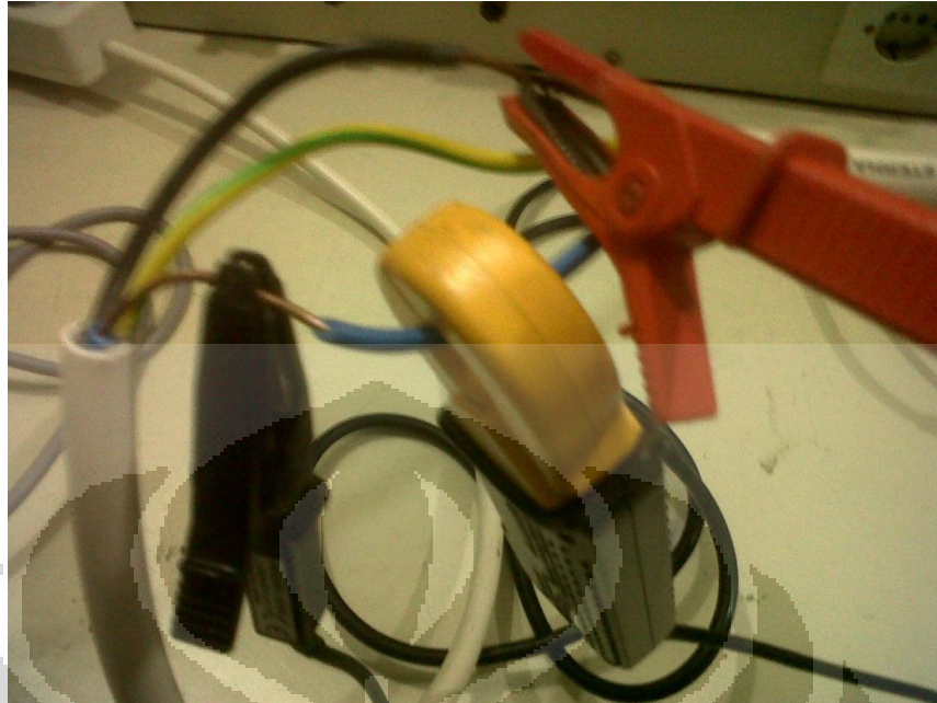
Gambar 4.6 Caput Penghubung Antara Input dan Kabel Tembaga
