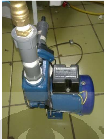
Gambar 3.6 Pompa sirkulasi air
