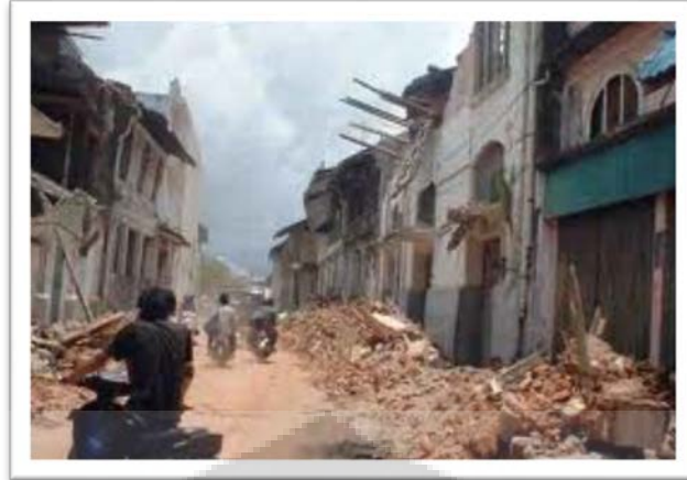
Gambar 4.3. Kawasan Pusat Kota Lama yang Rusak Akibat Gempa
