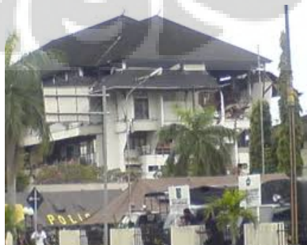
Gambar 4.1. Kantor walikota Padang yang rusak Akibat Gempa
