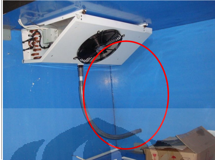
Gambar 3.29. Sistem defrost pada cold storage
