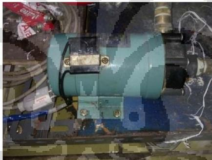
Gambar 4.7 Pompa *weak solution* dari absorber ke generator
