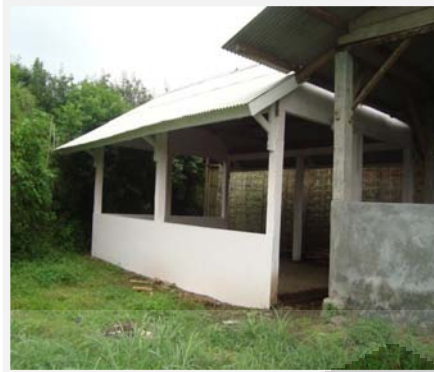
Pembangunan gedung gudang kompos di Dsn. Gondang, Ds. Tulungrejo, Kec. Bumiaji
