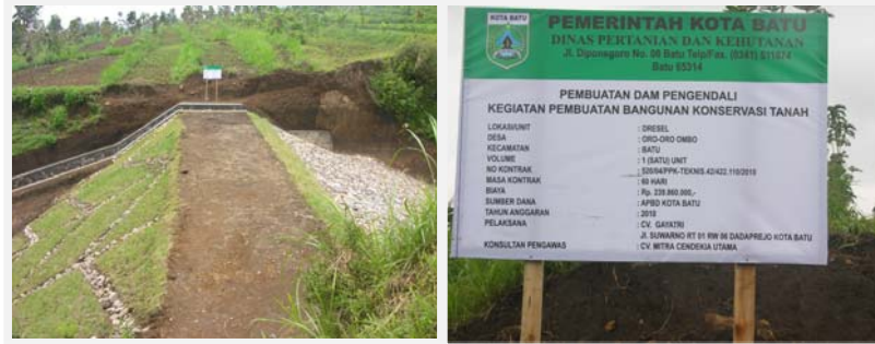
Pembuatan bangunan konservasi tanah/dam pengendali di Desa Oro-Oro Ombo
