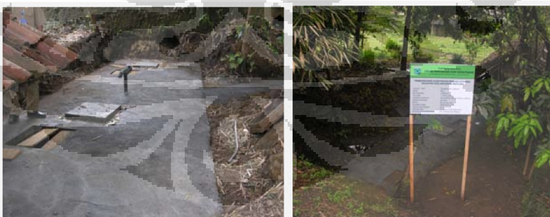
Pembangunan unit perlindungan mata air berupa bangunan konstruksi reservoir (brouncuptering) di Desa Beji
