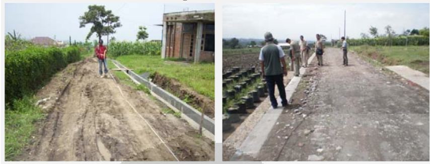
Pembangunan Jalan Usahatani di Dusun Pandan Desa Pandanrejo Kec.
