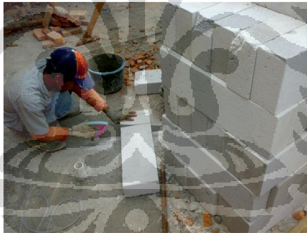
Gambar 2.11. Beton ringan aerasi. Material ini dapat dipotong dengan mudah sesuai dengan kebutuhan
