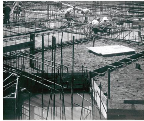
Gambar 3. 4 Penulangan Tie Beam
