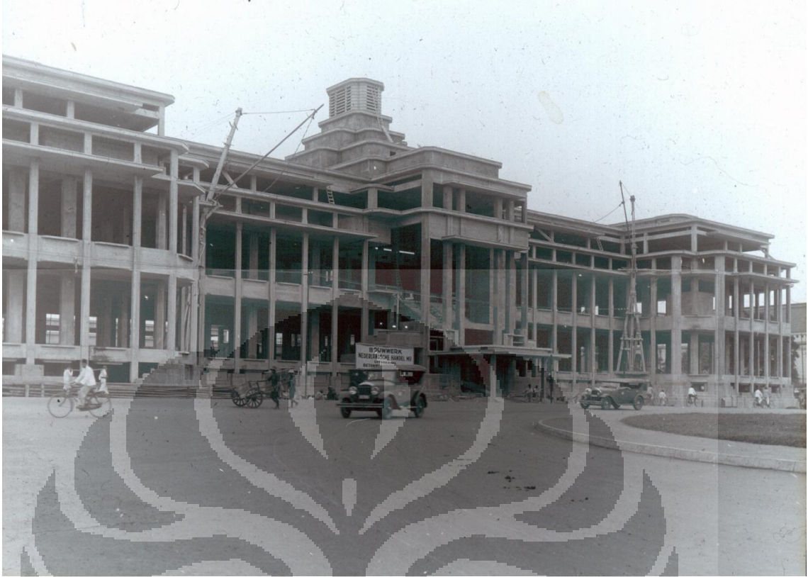
Gambar 3. 9 Selesaiya Struktur Beton
