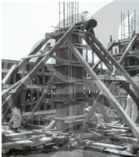
Gambar 3. 5 Bekisting Kolom
