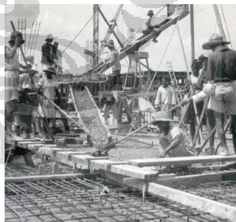
Gambar 3. 8 Proses Pengecoran
