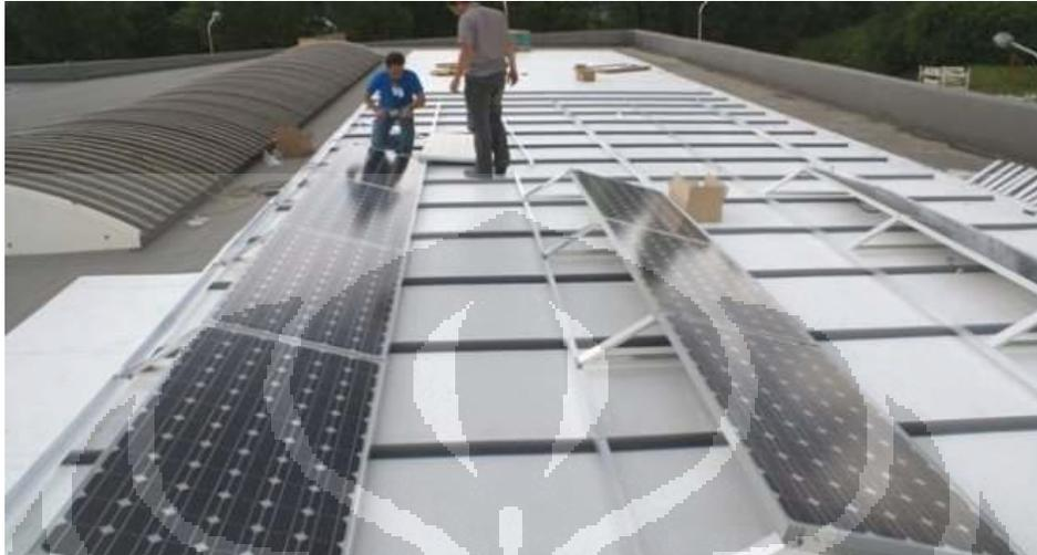
Gambar 4.7. Pemasangan PLTS secara *on grid* pada gedung *commercial*
