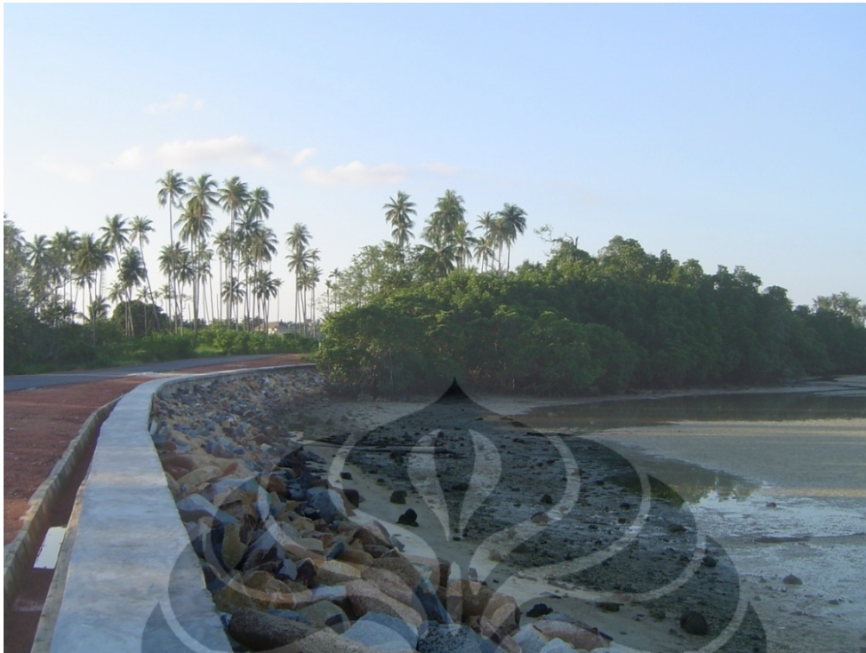
Gambar 5.5 Jalan dan tanggul yang dibangun karena erosi
