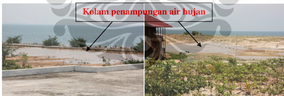
Gambar 4.19. Penampungan air hujan yang airnya digunakan untuk memenuhi kebutuhan sehari-hari oleh pasukan penjaga pulau Nipa. Sumber : Koleksi pribadi
