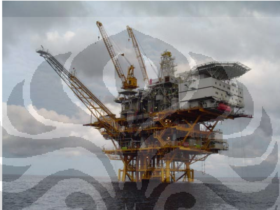
Gambar 2.2. Well head Platform X (WHP-X) dengan paket pengeboran di atasnya
