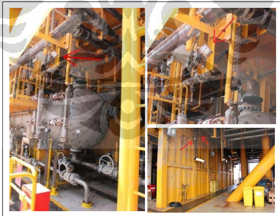
Gambar 4.2. Alat Deteksi Api ( flame detector )
