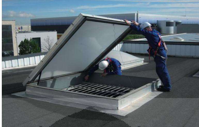
Figure.2. Un exemple de l'ouvrant en toiture terrasse
