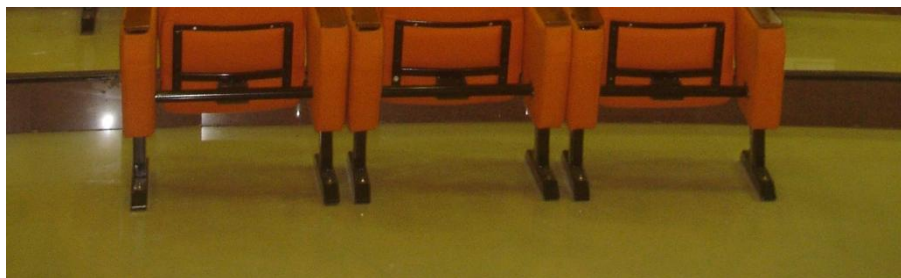
Gambar 4.6 Lantai Keramik pada Ruang Auditorium K301
