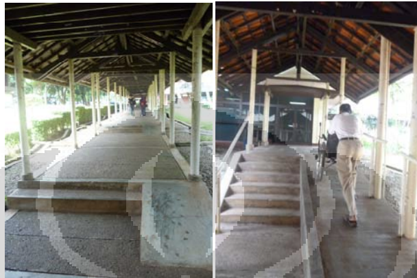
Gambar 3.27 Ramp menuju gedung 8 (kiri)
