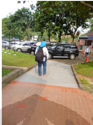
Gambar 3.39 Ramp yang terdapat di depan gedung A
