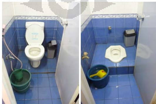
Gambar 3.47 Kondisi toilet gedung A (kiri dan kanan)
