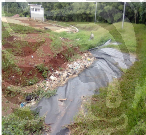
Lapisan Geomembran
