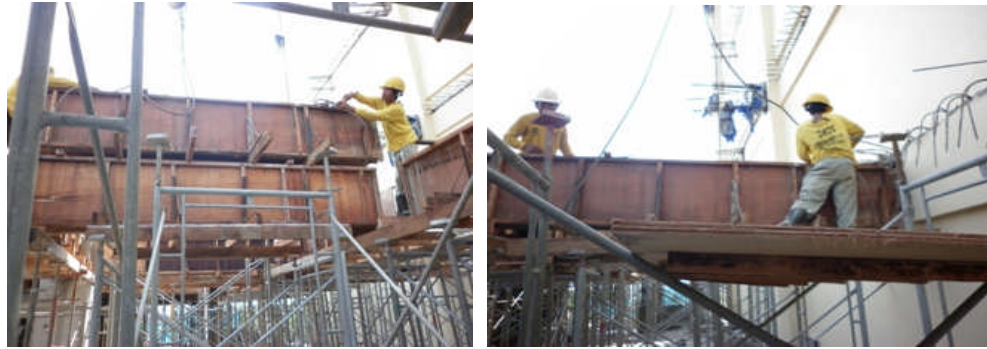
Gambar 6.4. Pemasangan bekisting
