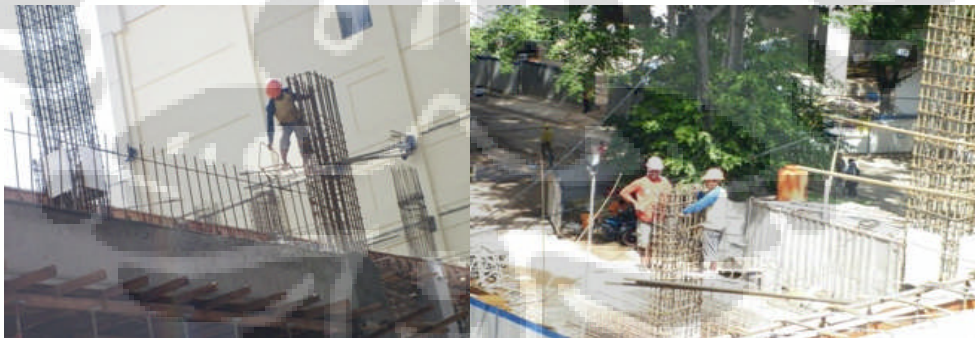
Gambar. 6.1. Proses pemasangan ring kolom
