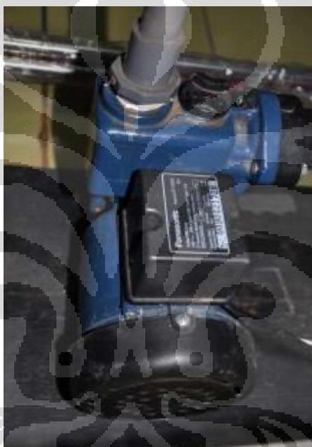
Gambar 3.2 Pompa Sentrifugal
