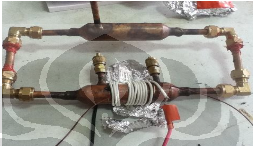
Gambar 3. 11 Pemasangan Pemanas elektrik.
