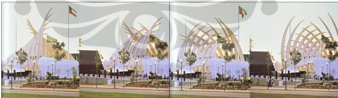
Gambar 3.32 Proses terbuka dan tertutup kuwait pavilion sumber: san tiago calatrava's creative process sketchbooks p.222
