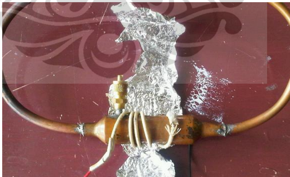
Gambar 3.11 Pemasangan heater kabel.
