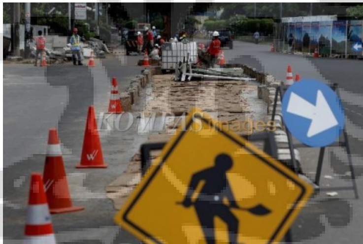
Pekerja menyelesaikan pembangunan jalan layang Antasari-Blok M Jakarta, Selasa (4/1/2011).
