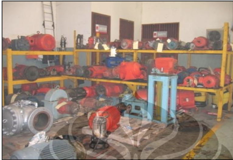
Gambar 4.3 Penyimpanan Spareparts yang Tidak Rapi
