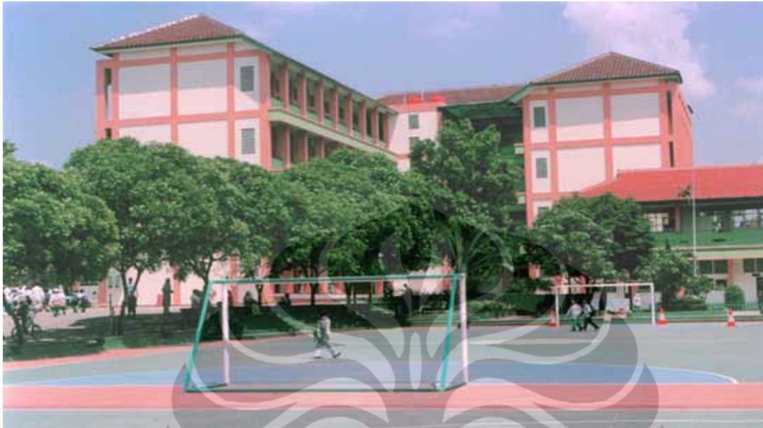
Gambar 2. Gedung Madrasah Pembangunan, Ciputat Tangerang Selatan
