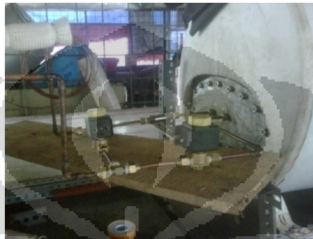
Gambar 3.18 Tube serpentine dan tutup tangki dipasang pada badan tangki
