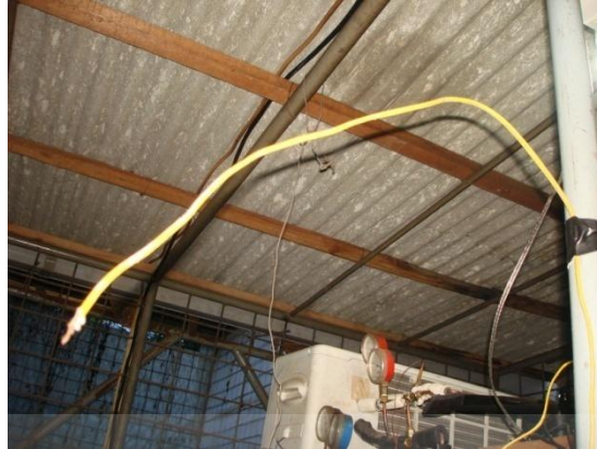
Gambar 3.32 Posisi termokopel untuk pengukuran temperatur lingkungan
