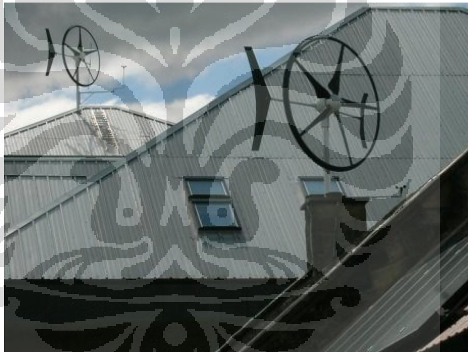
Gambar [2.7] Turbin angin skala kecil pada atap rumah
