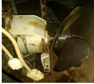
Gambar 3. 2 Fan kondensor merk Maspion Elektrik 19 W.
