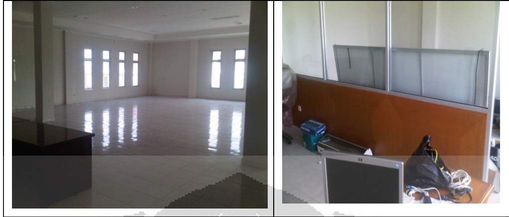
Gambar 4.9 Rencana Ruangan Data Centre
