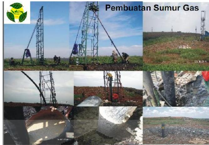
**Gambar 3.2** Pemasangan Sumur Gas
