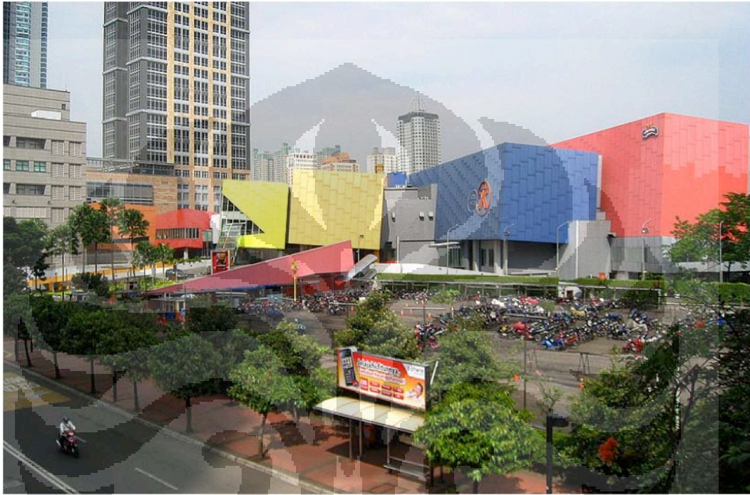
Gambar 3.1. Bangunan Entertainment X'entre
