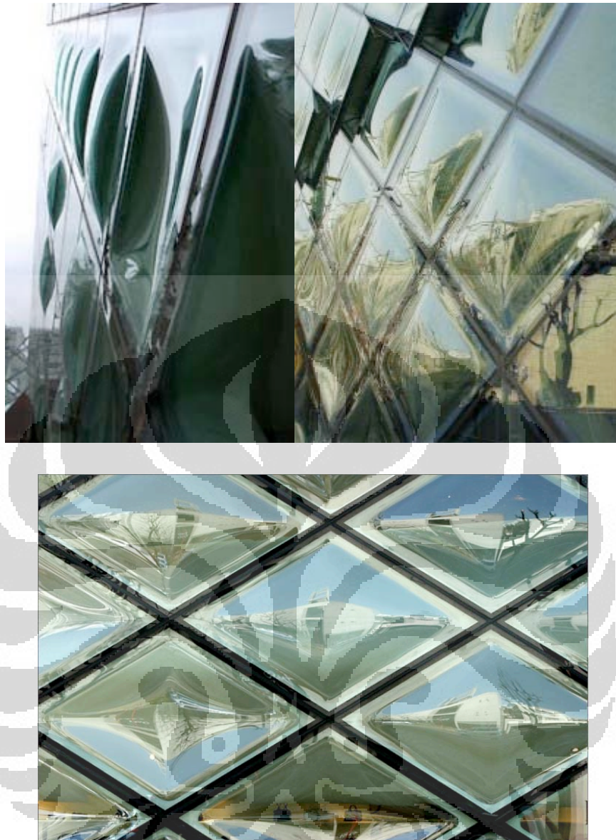
Gambar 4.11: Tampilan perbedaan jenis kaca yang digunakan pada fasad Prada Aoyama Epicenter
